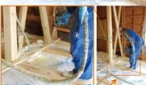
発泡ウレタンは 非常に軽いので シートの上に吹付けます。
